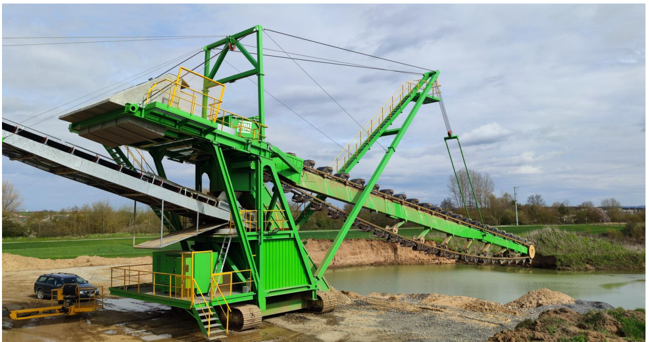
Abbildung 5-2: Geplanter landgestützter Eimerkettenbagger, derzeit in Dettelbach im Einsatz
