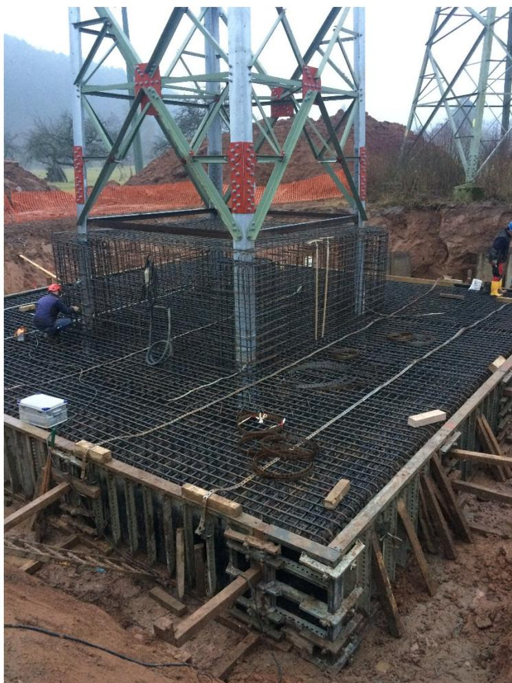
Abbildung 23: Beispiel für Fundamentarbeiten, Schalung und Bewehrungsstahl
