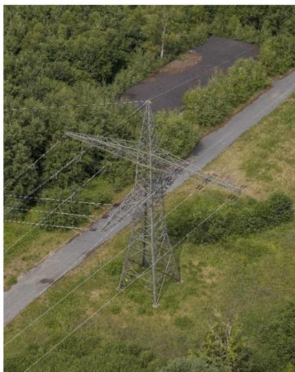
Abbildung 5: Einebenenmast mit Kreuztraverse
