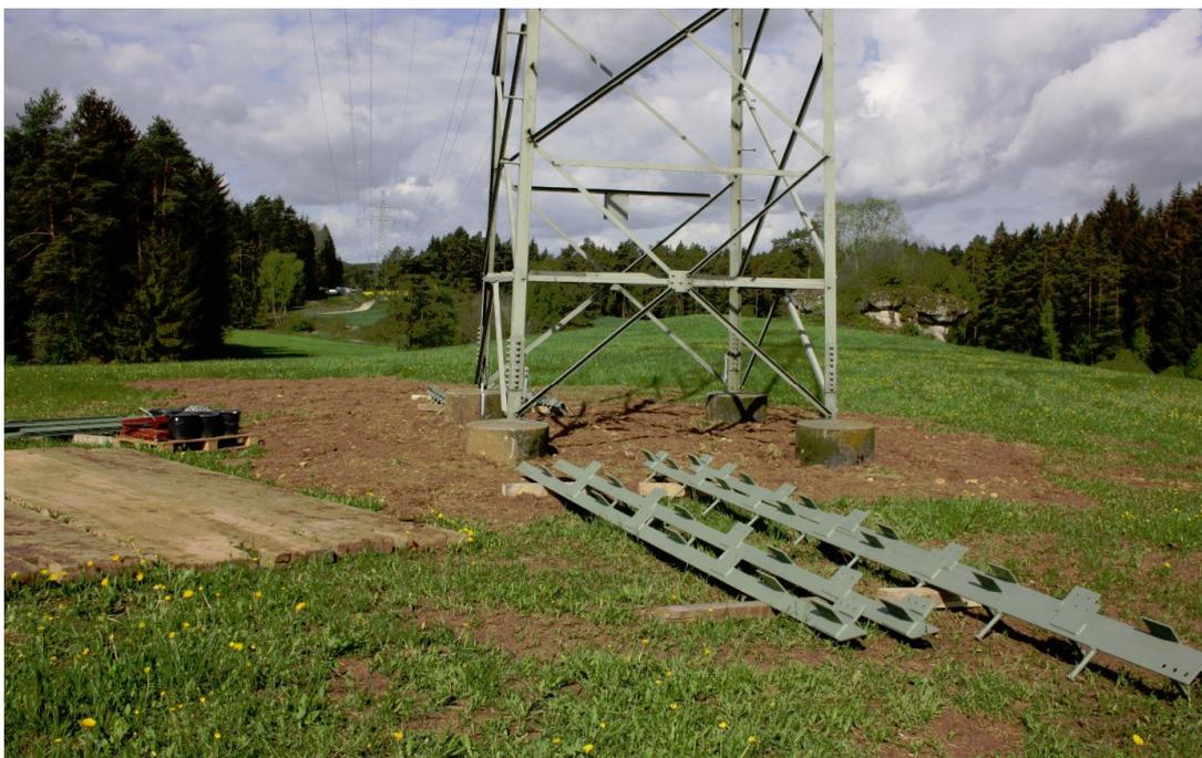
Abbildung 21: Mastverstärkungsteile mit Arbeitsfläche
