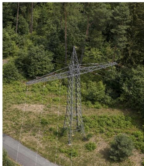
Abbildung 6: Einebenenmast (Mast 59)
