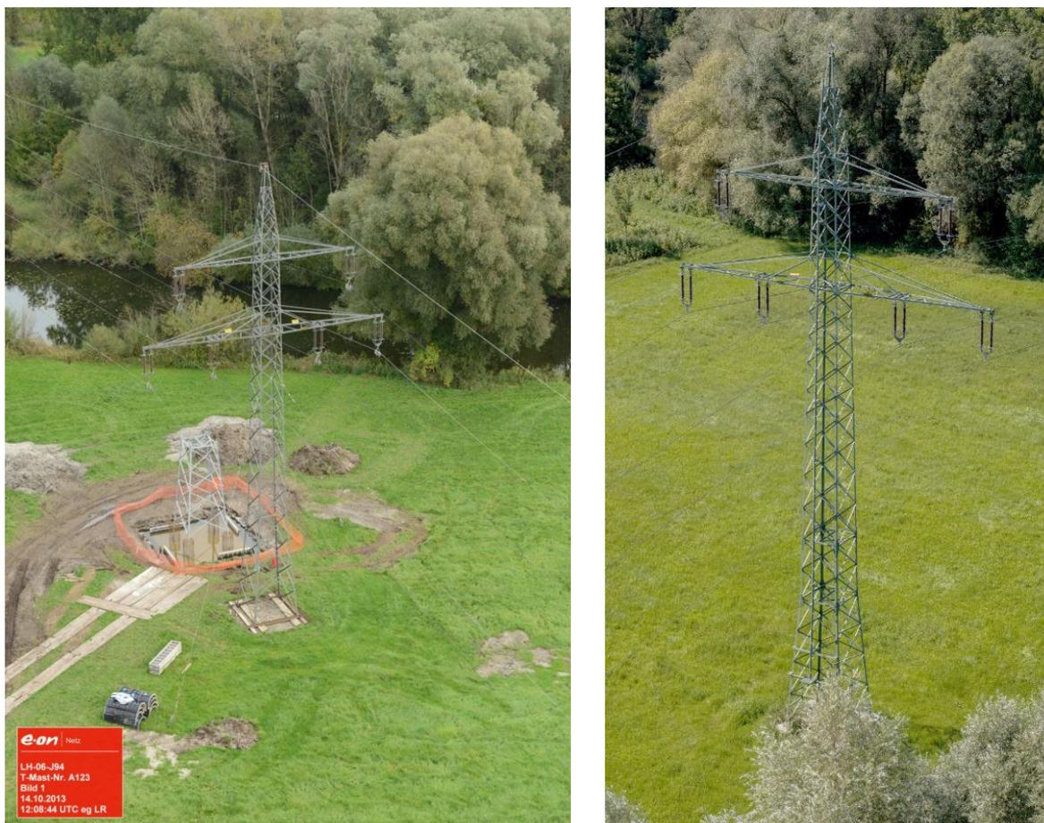
Abbildung 16: Arbeitsfläche 2013 für den Einbau eines neuen Unterteils des Masts A123 Ltg Nr. J94 (links) im Vergleich zur vollkommen regenerierten Fläche 2017 (rechts)
