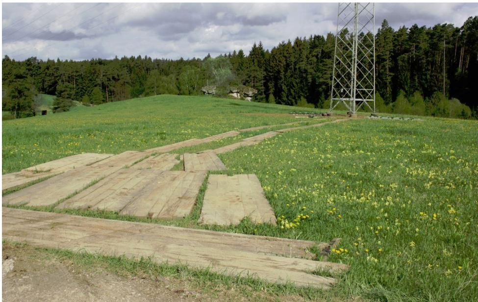
Abbildung 14: Zuwegung über Holzplatten (leichter Wegebau)
