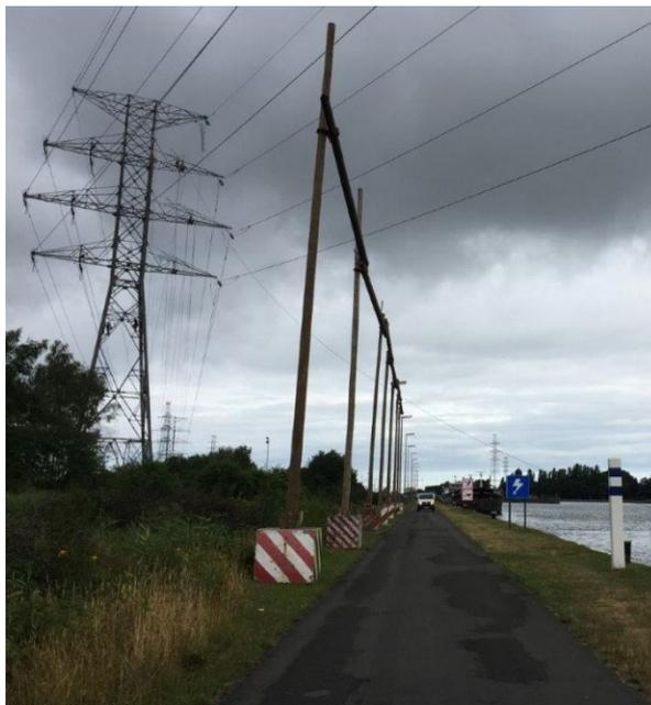
Abbildung 25: Schutzgerüst ohne Abankerung
