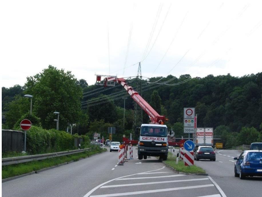
Abbildung 24: LKW mit Hebebühne als mobiles Schutzgerüst
