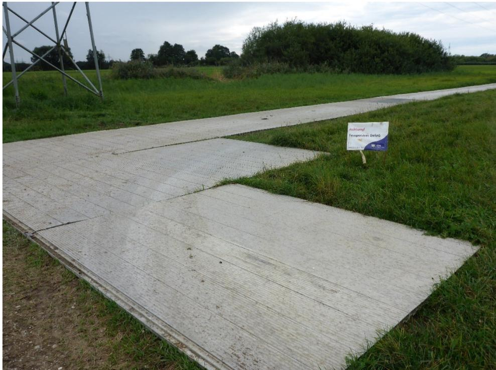
Abbildung 13: Zuwegung über Aluplatten (schwerer Wegebau)
