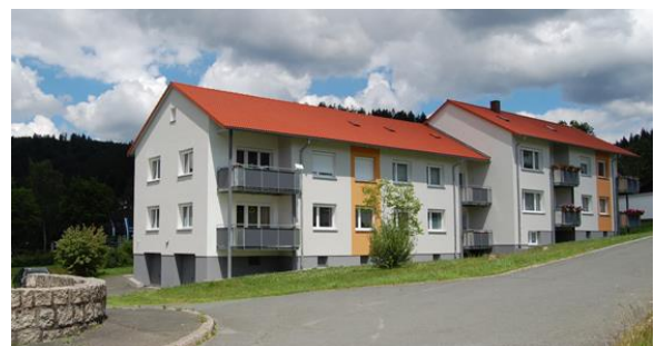
© Regierung von Oberfranken
